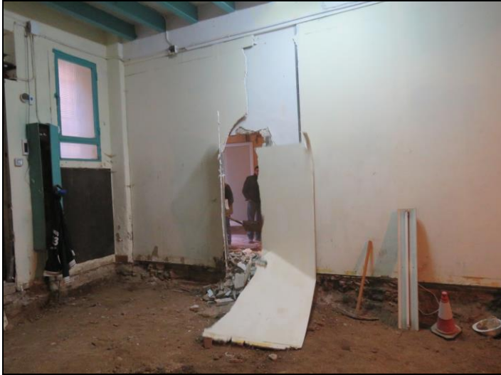
Realització de pas entre locals
