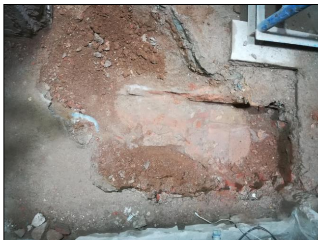
Vista de la capa de ciment i restes del paviment de rajoles
